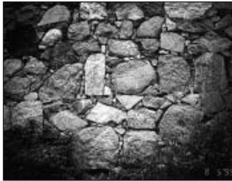
**Abb. 12** Zyklopenmauerwerk in handwerklich gut ausgeführter Zwickeltechnik
