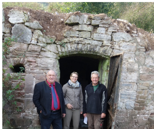
Bei der Sicherung des Gewölbekellers als Winterquartier für Fledermäuse: (v. l.) Egon Primas (MdL und Vereinsvorsitzender des LPV Südharz/Kyffhäuser), Sarah Backhaus (Projektleiterin des ENL-Projektes) und Herr Meyk Forst (von beauftragter Baufirma). Foto: LPV Südharz/Kyffhäuser.
