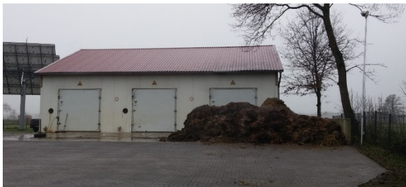
Feststofffermentationsanlage mit 3 Kammern, welche mit Mist und Landschaftspflegematerial befüllt werden.
