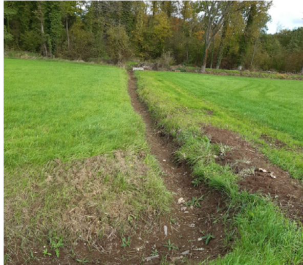
Für die Überleitung von Wasser aus dem Wiesenbereich in den Wald wurde ein alter Graben reaktiviert, Foto: Keller
