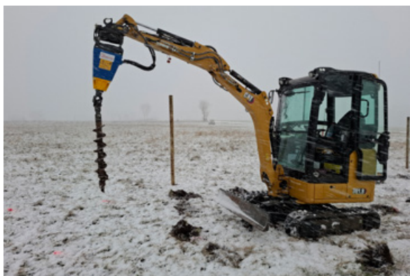
Bohrgerät am Bagger im Einsatz bei der Heckenpflanzung, Foto: LPV Hersfeld-Rotenburg
