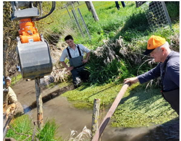
Einbau Faschinen und Wurzelstöcke, Foto: B. Dahinten, LPV Weidenberg
