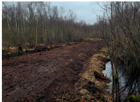
Dichtbahn im Moor mit Verwallung, Foto: Naturschutzing Aukrug
