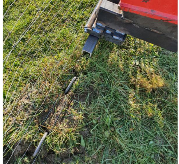
Maschinelles Einbringen von Armierbögen als Untergrabschutz. Pro laufendem Meter werden 5 Bögen eingebracht. Wichtig ist der Anschluss an den Zaun, die Armierbögen werden in den untersten Draht eingefädelt. (Fotos: J. Hofbauer, Maschinenring Mittl. Bayer. Wald)
