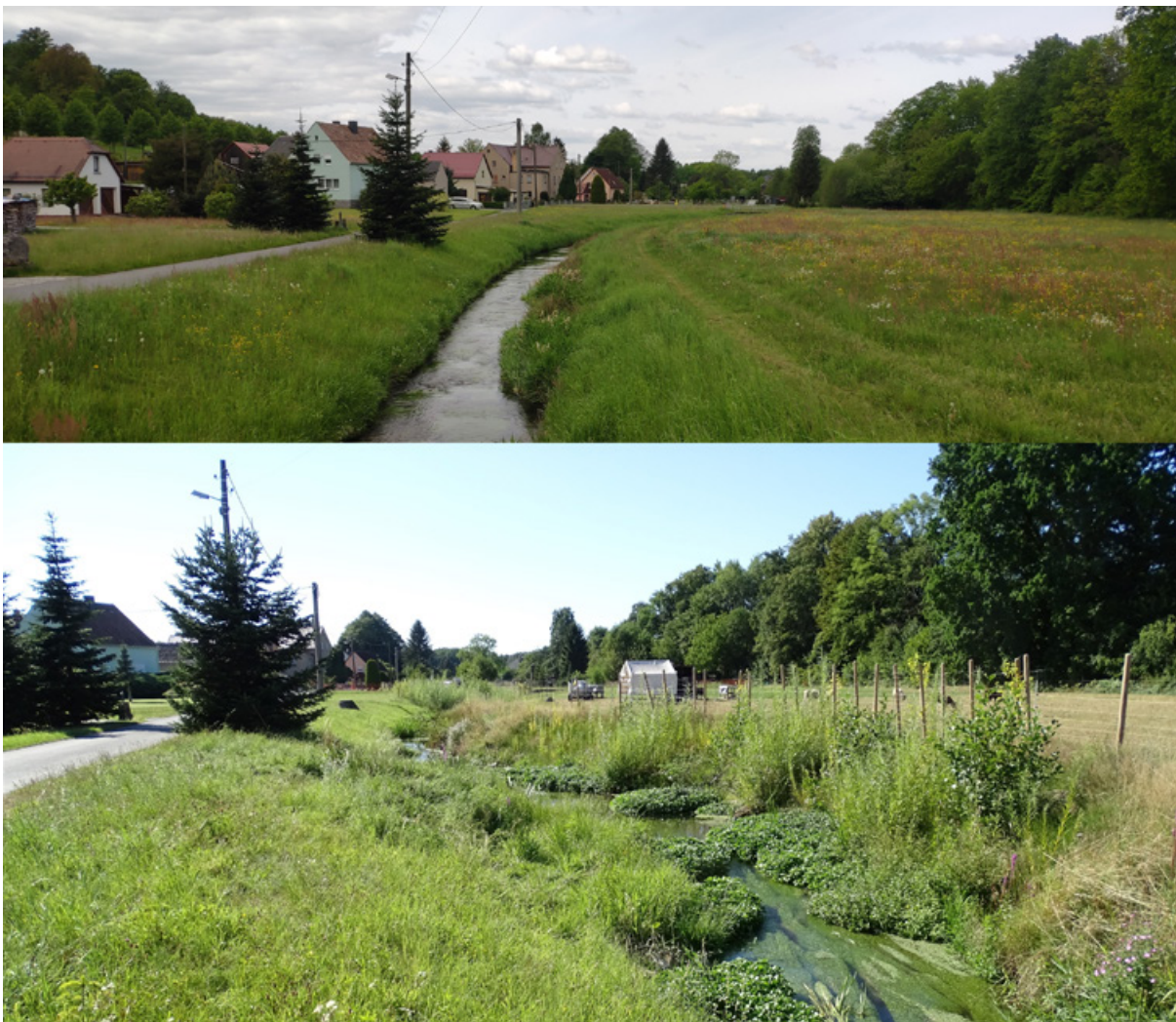
Vorher-Nachher-Vergleich des oberen Maßnahmenabschnitts. 5 m breite Aufweitung auf der rechten Uferseite, teilweise Einbau des Erdmaterials auf der linken Uferseite zur Schaffung eines Gleithanges, ausgetriebene lebende Bauweisen aus Hanfweide, Schwarzerle und Bündelpflanzungen an der Böschungsoberkante. Fotos: DVL (oben), LfULG (unten)
