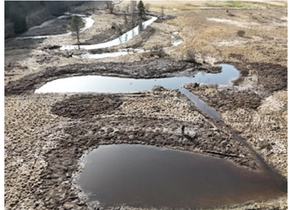
Das Areal nach der Fertigstellung von oben gesehen. Foto: UNB Schwarzwald-Baar-Kreis
