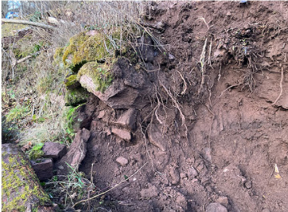
Abb. 2: Zunächst wurden die Steine abschnittsweise abgetragen (links). Große Steine wurden mit dem Sortiergreifer beiseitegelegt, kleine Steine für die Hintermauerung wurden mit dem Sieblöffel (rechts) aus dem Gemisch gesiebt. Fotos: Fabian Anger
