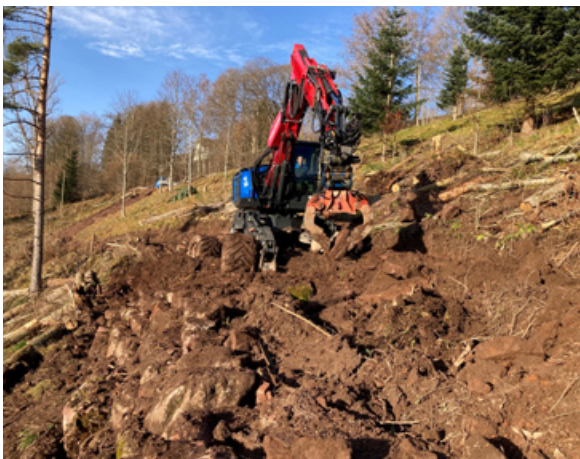
Abb.: 3a: Stück für Stück wurde die Mauer wieder aufgesetzt. Foto: Albert Koch
