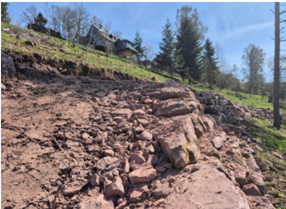
Abb. 5: Die Abbruchkante der Ebene wurde mit der Baggerschaufel so angerissen, dass eine Erdwand als Nistmöglichkeit für Wildbienen entstanden ist. Foto: Joana Czermin
