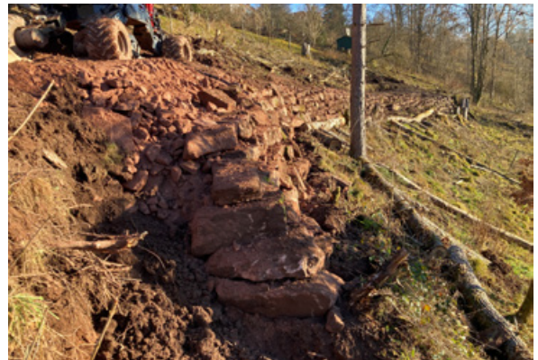
Abb. 3b: Beim Aufsetzen der Mauer wurde auf eine lückige und auf der Mauerkrone nicht übererdete Hintermauerung geachtet. Foto: Albert Koch
