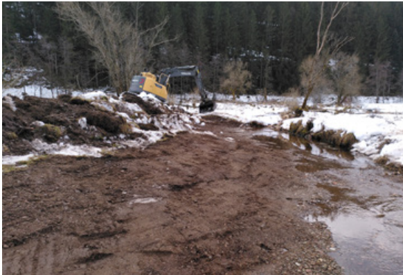
Größere Erdarbeiten waren nötig, um am Altarm der Breg wieder mehr Dynamik zu schaffen. Foto: LEV Schwarzwald-Baar-Kreis
