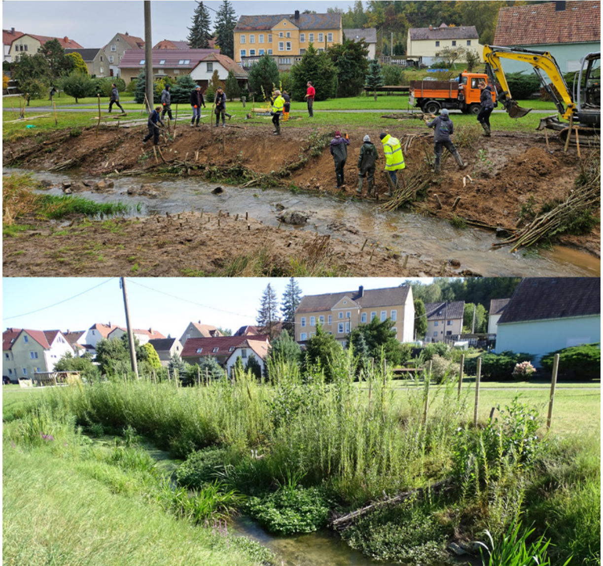
Vorher-Nachher-Vergleich des unteren Maßnahmenabschnitts mit Ansicht während der Bauphase. Aufweitung am in Fließrichtung linken Ufer, Einbau von strömungsparallelen Lebendfaschinen am Böschungsfuß des hergestellten Prallhangs, geneigte Lebend- und hinterpflanzte Totfaschinen sowie Steckhölzer an den Uferböschungen und Bündelpflanzungen an der Böschungsoberkante. Foto: DVL (oben), LfULG (unten)
