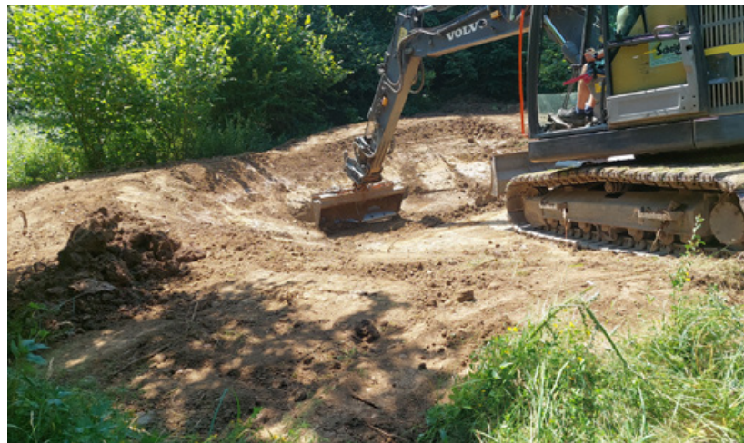
Erdarbeiten für die Himmelsteiche am Hachenbach. Foto: C. Guillet, LPV MR-BID
