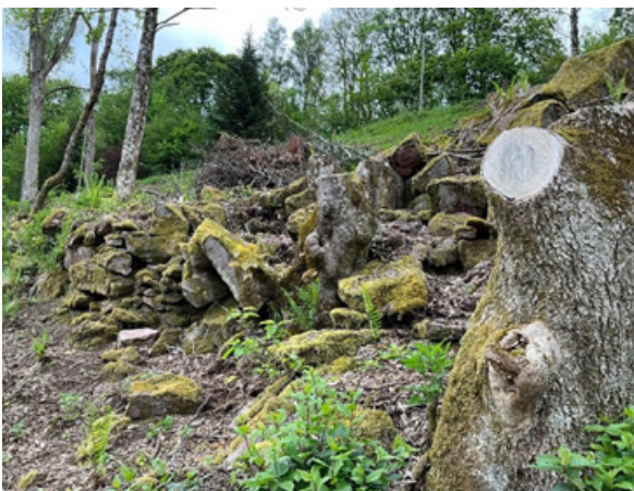
Abb. 1: Stark aufgelöster Mauerverbund nach Freistellung der Fläche im Jahr 2024. Foto: Joana Czermin
